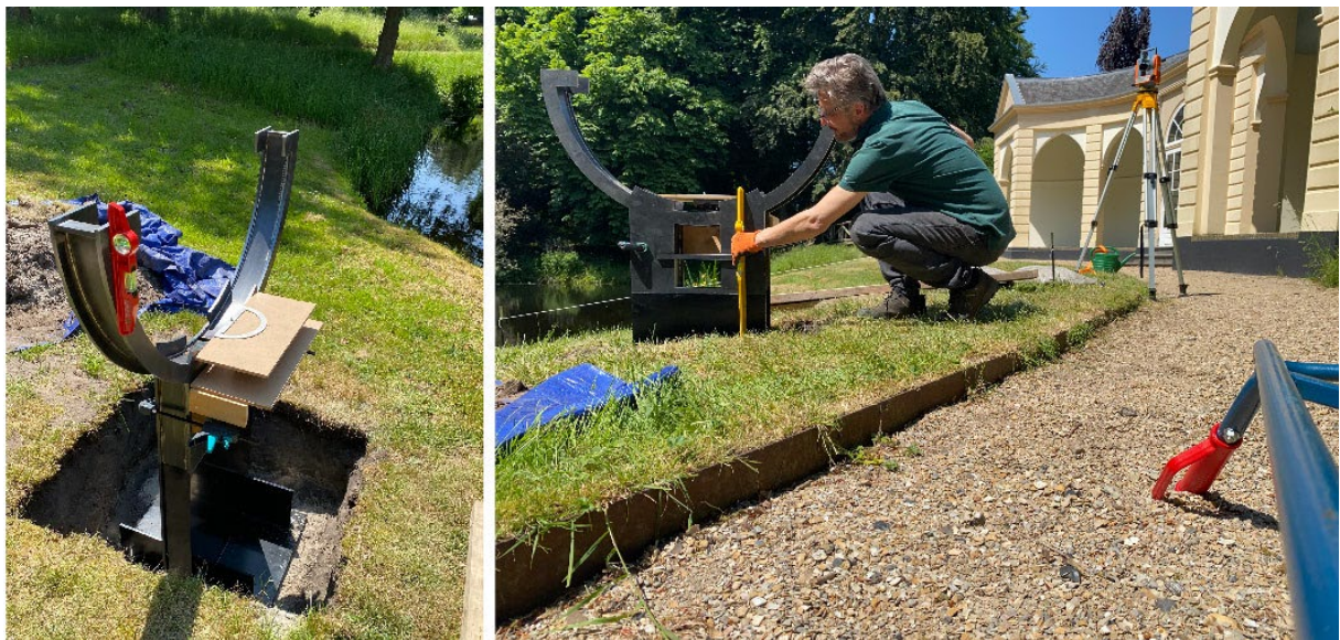
Figuur 9: stellen van de voet, de theodoliet staat op de achtergrond bij het theehuis
